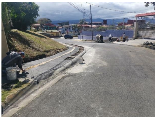
Construcción de acera cordón de caño en el sector de Calle Tierras de GOSEN.
