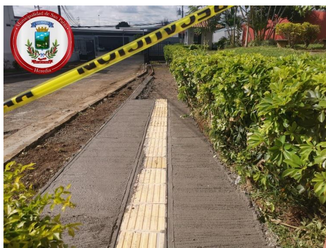
Construcción de acera cordón de caño en el sector de Urb. Compostela.
