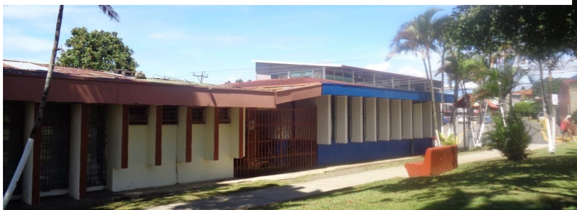
Foto 7 -Sede del Área de Salud de San Pablo y San Isidro.
